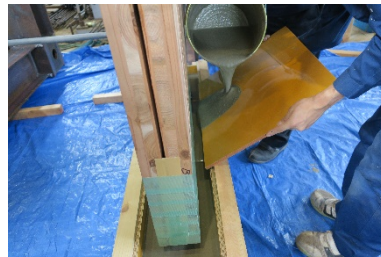
モルタル施工中
