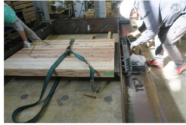
CLT パネルの留め付け
