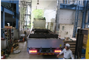
鉄骨フレーム搬入
