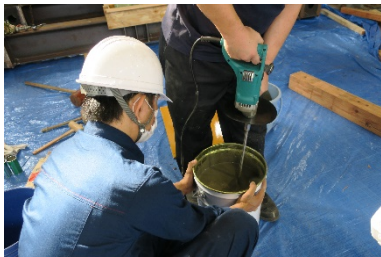
モルタル練り混ぜ
